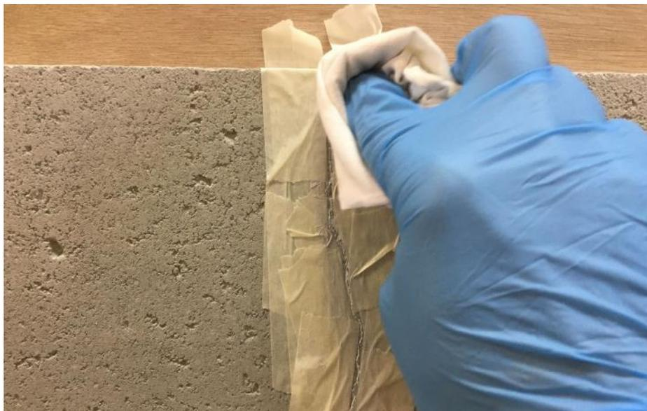
**3.** セメントを指に付け、ジョイントコークの上に付けていきます。ジョイントコークだけでは色身が合いませんが、セメントを表面に重ねることで、色合いが近くなります。
