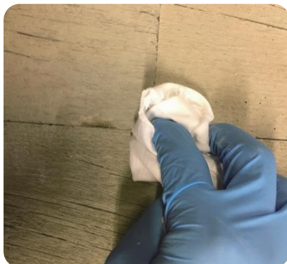
Step6 : ウエスで軽くふき取り補修は完了です
