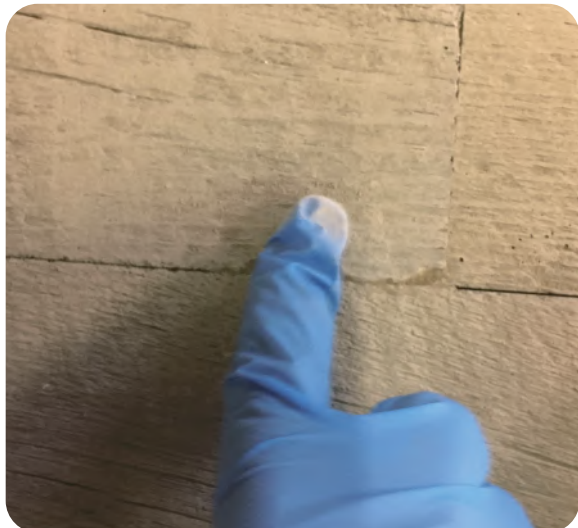
Step5 : マスキングテープをはがし、はみ出したジョイントコークに、専用セメントを馴染ませます
